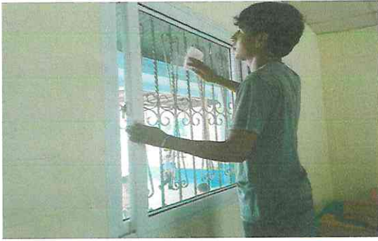
Foto1: Cambio de ventanas de paleta por ventanas de pvc.
