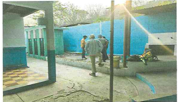
Foto 6: Losa de patio colocación de concreto.
