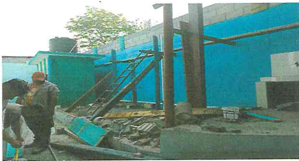
Foto 5: Reparación de muro de contención.
