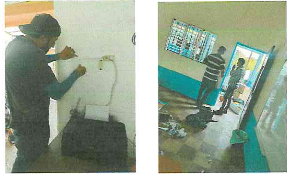
Foto 2: Cambio de apagadores y tomacorrientes.
